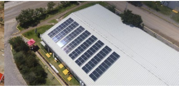
Paneles solares en el edificio de administración de la mina San José
