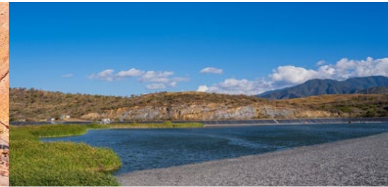
Presa de relaves en la mina San José
